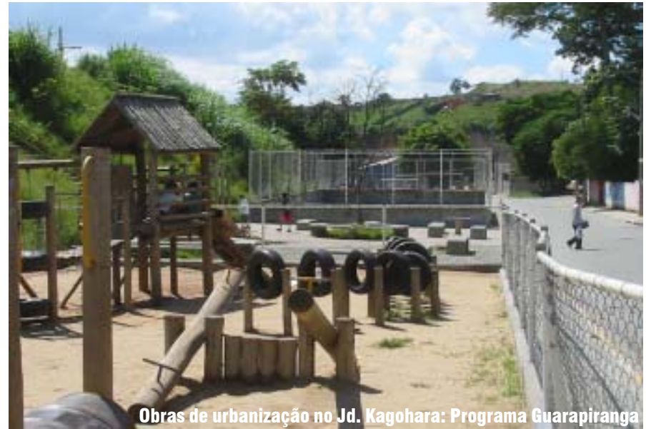
Obras de urbanização no Jd. Kagohara: Programa Guarapiranga
