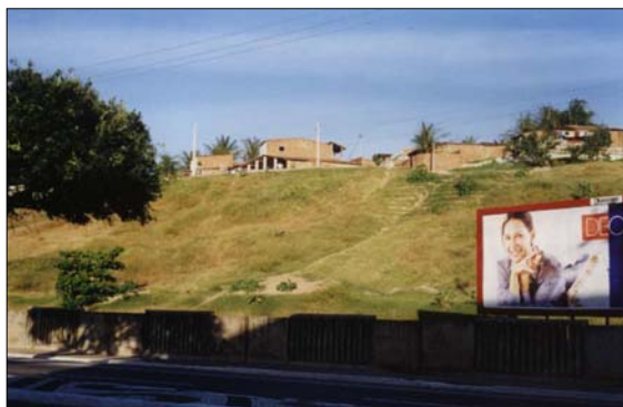
Foto 11 – Área da encosta após as obras de contenção
