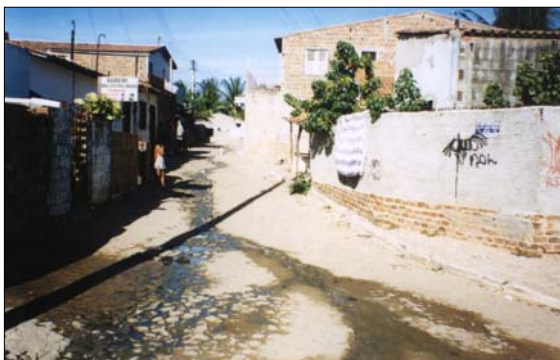
Foto 8 – Área nas proximidades da encosta, com declividade acentuada e recorrência de problemas de drenagem de águas superficiais
