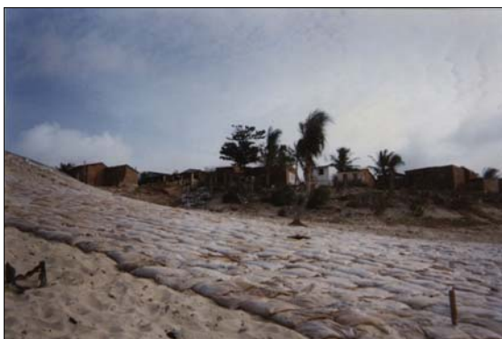
Foto 10 – Área da encosta durante as obras de contenção
