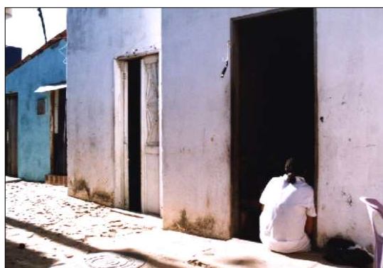
Foto 3: Observar o desnível entre a soleira da casa e seu interior
