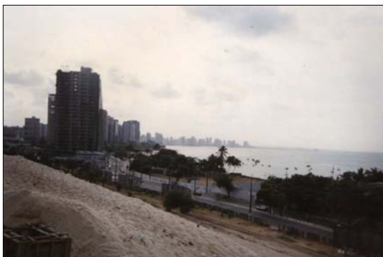
Foto 9 – Área da encosta anterior às obras de contenção
