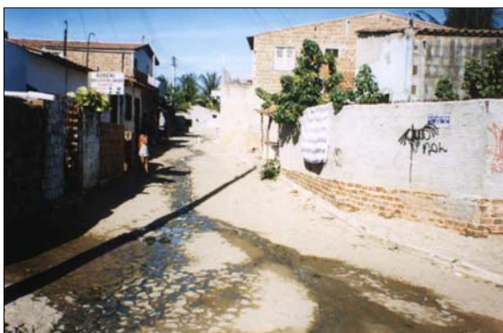
Foto 7 – Deficiências no sistema de esgoto após a urbanização
