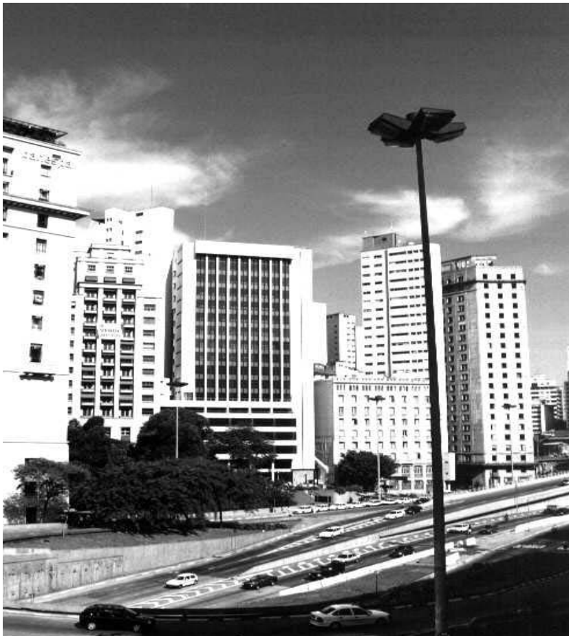
Figura 2: Vale do Anhangabaú, edifícios vagos. Edifício Hotel São Paulo – estudo atual de viabilidade pelo PAR.
